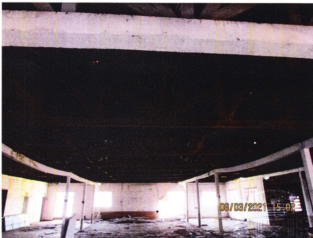
Imagem 06 – Visão geral da estrutura do telhado
