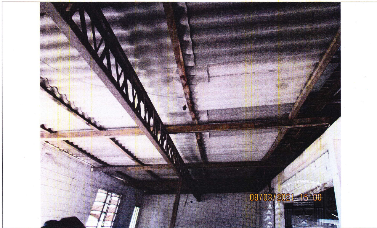
Imagem 12 – Estrutura telhado da copa e Folhas de Brasilit
