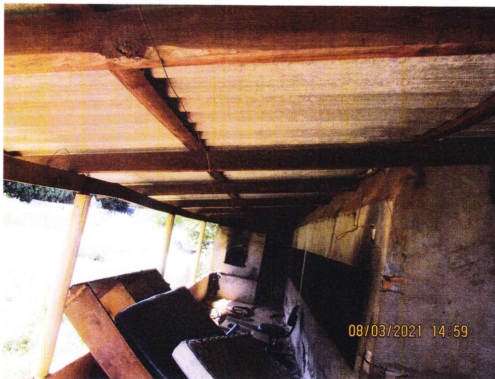
Imagem 01 – Detalhes estrutura de madeira e telhado churrasqueira- área externa
