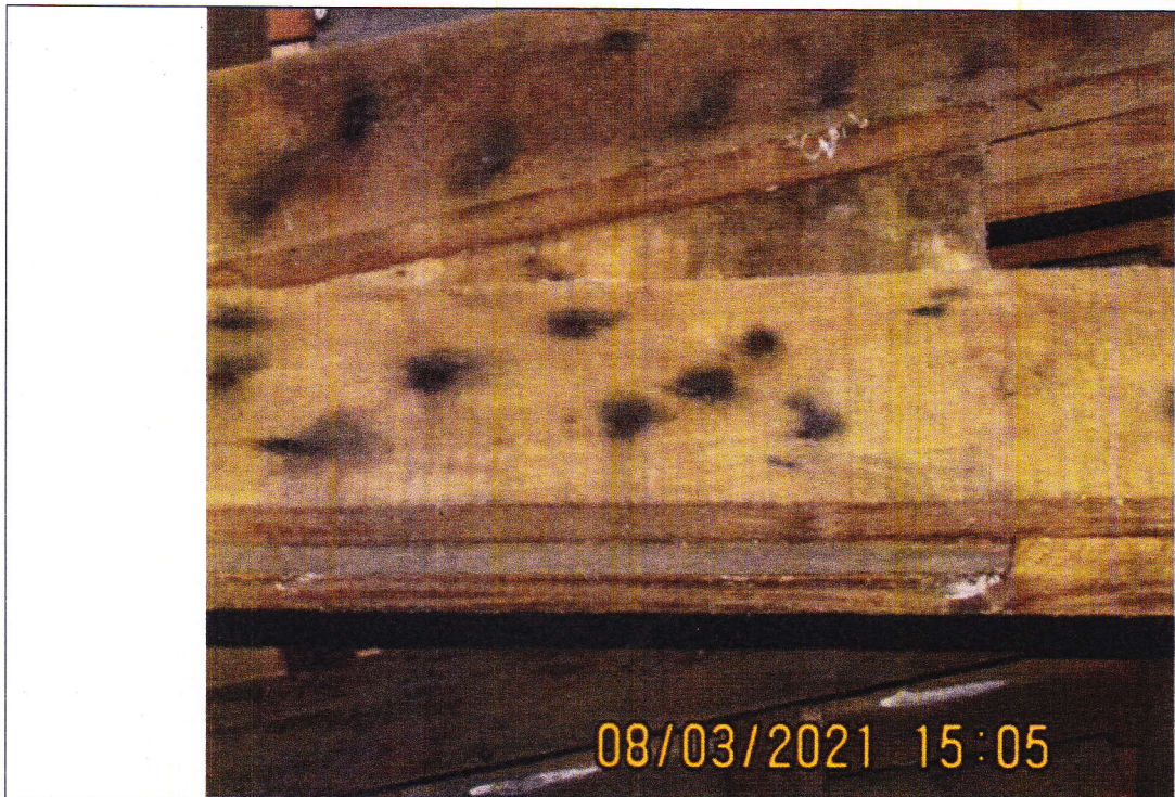
Imagem 09 – Ênfase embora a estrutura do telhado pareça de barrotes inteiriços são tábuas pregadas em 3 camadas
